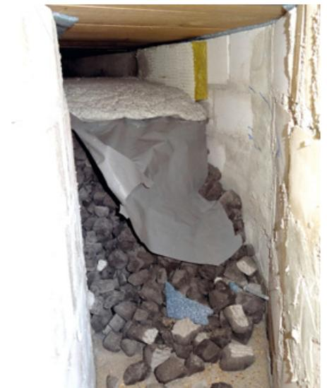
*Luftkollektoren im Solarturm sammeln warme Luft, die eine Hypokauste unter dem Bühnenboden heizt – träge, aber lang anhaltend.*
